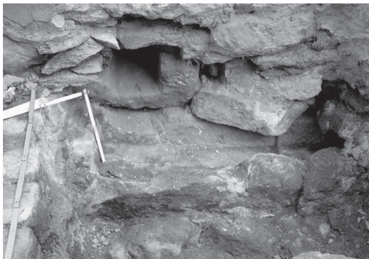
Obr. 7_ čp. 189 – pískovcový žlab v sondě 6/09 vně objektu.
